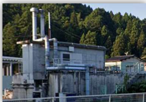
排水処理設備
